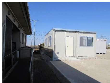
▲事務棟設置(3/21 撮影)
